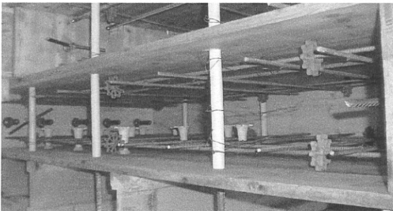
Bild 03 Schalung vor dem Betonieren
