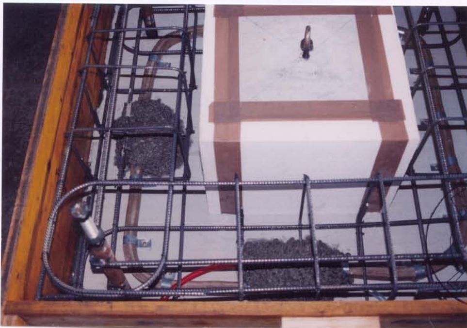
Bild 2: Einbau von 2 Kiesnestern zur gezielten Nachstellung von Inhomogenitäten im Sohle-Wand-Bereich
